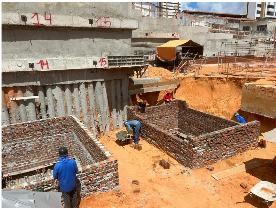
Figura 5. Montagem da forma dos blocos de coroamento dos elevadores (B12 e B14).
