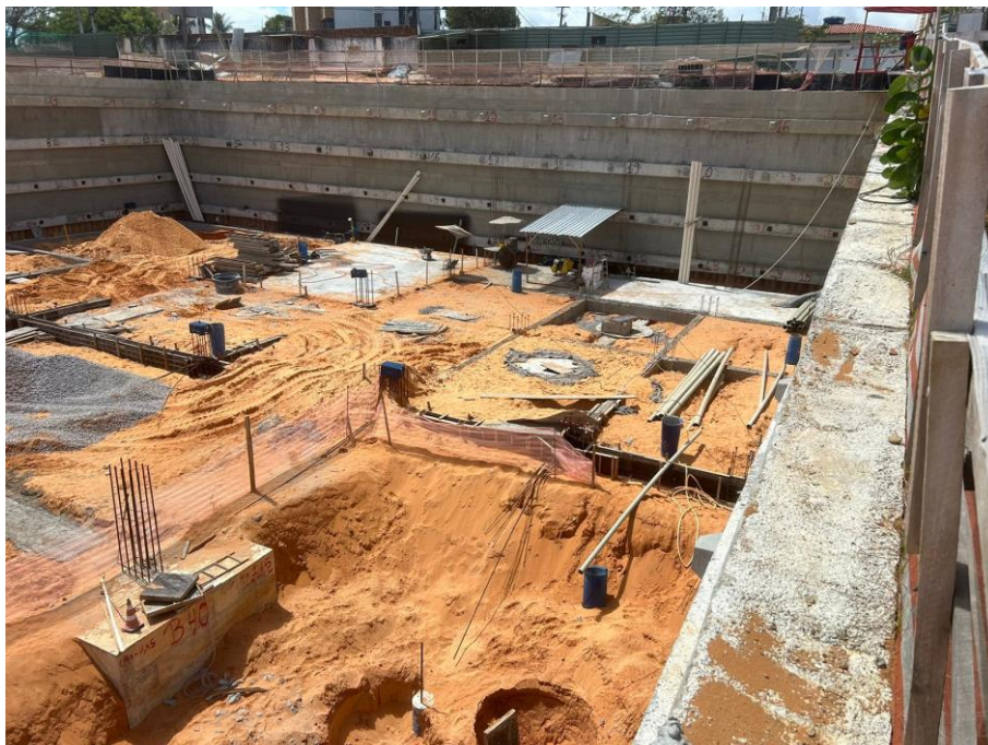
Figura 7. Vigas baldrame e lajes de piso.
