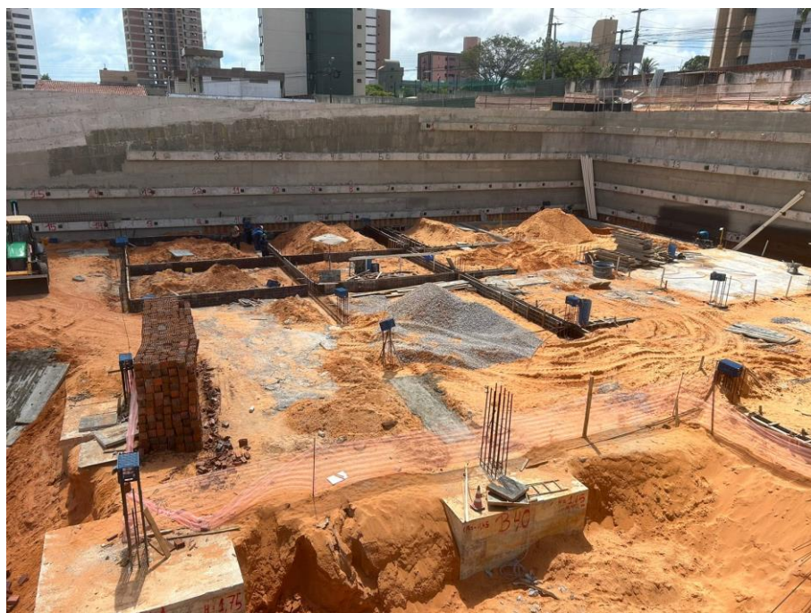
Figura 1. Visão geral da obra.
